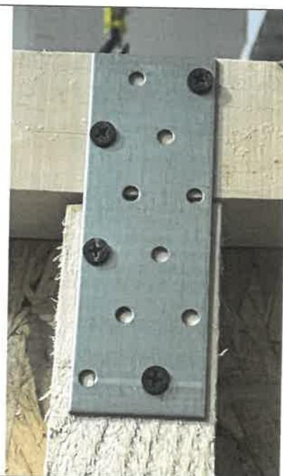
Рисунок 6. Крепление брусьев между собой на пластины и саморезы.
