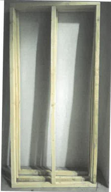
Рисунок 5. Каркасы из бруса с номинальными размерами 2500×1200 мм.
