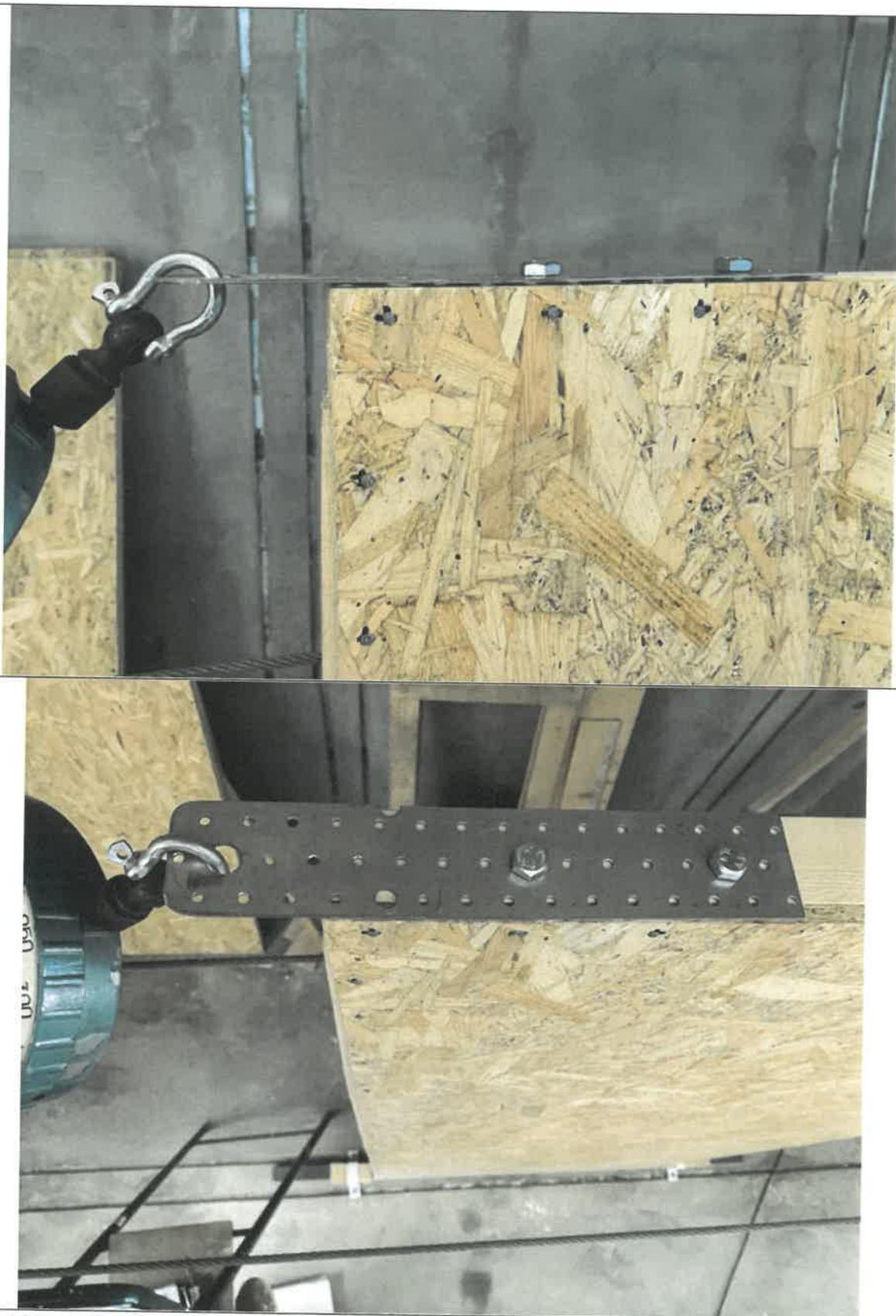
Рисунок 13 Крепление для плит ОСП-3 КАЛЕВАЛА тип OSB-3
