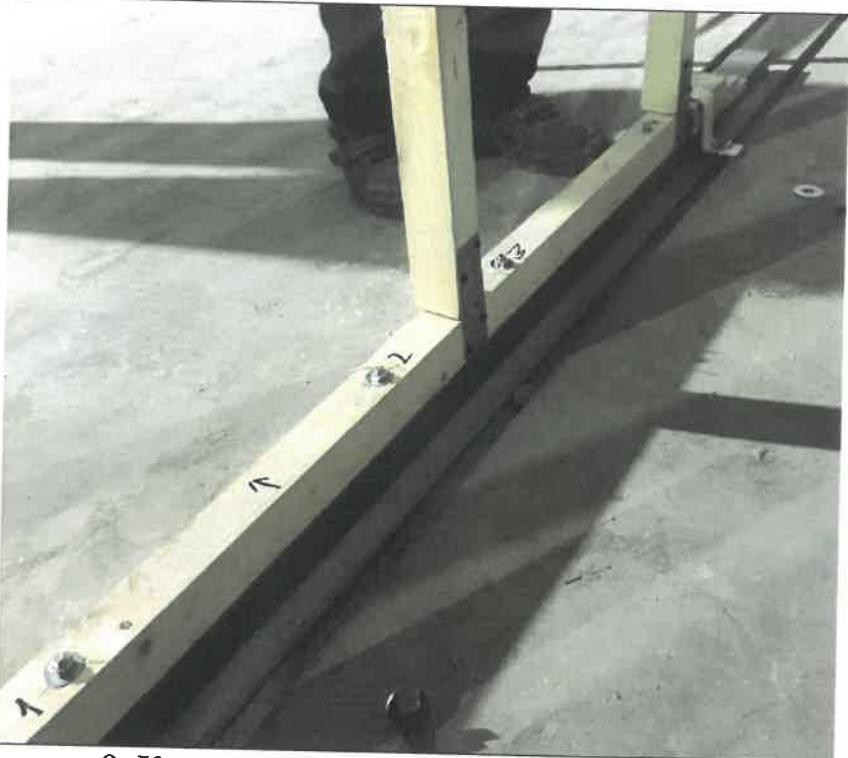
Рисунок 9. Крепление каркаса к металлической балке на болты
