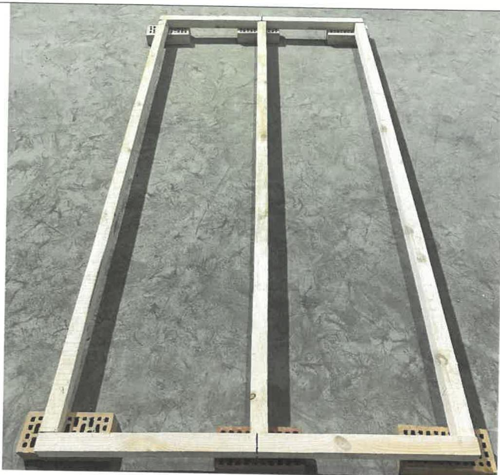
Рисунок 4. Каркас из деревянного бруса с размером 2500×1200 мм.
